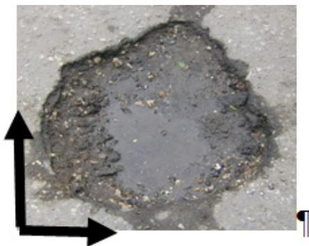
Рис. 1. Изображение выбоины на асфальте дорожного полотна
